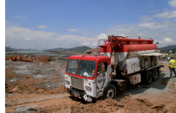
Voladura subacuática en la ampliación del Canal de Panamá y trabajos al pie del terreno.
